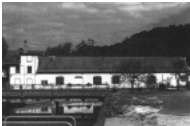
Le bâtiment des pompes 1 : façades nord et sud
