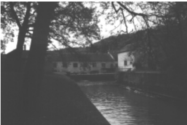
Le canal de fuite
