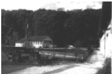
Au premier plan le bâtiment comprenant l'atelier, au second plan le bâtiment administratif dans le prolongement du bâtiment des pompes 1
