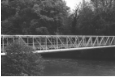
La passerelle piétonne
