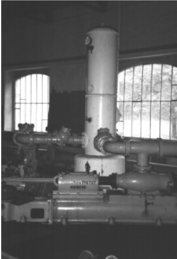
La turbine n°2 Gérard, Piccard-Pictet (1905?) dans le bâtiment des pompes 1
