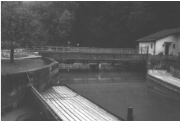
Le bassin d'amenée
